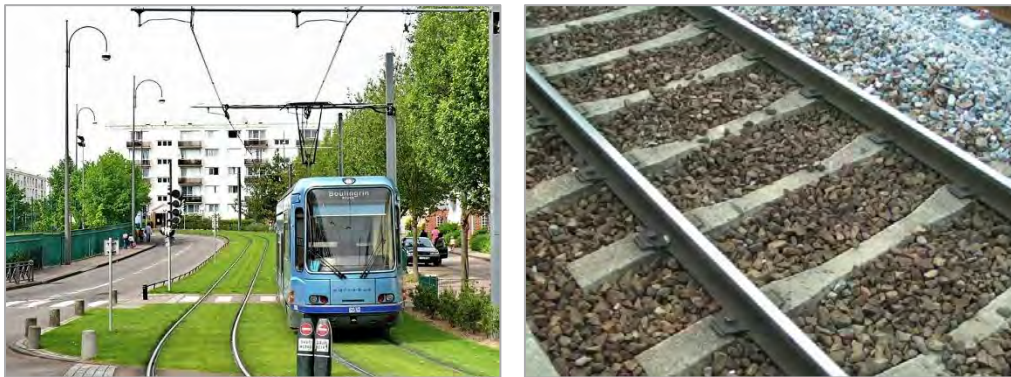
Figure 126 : Exemples de revêtements de plateformes : gazon et ballast
